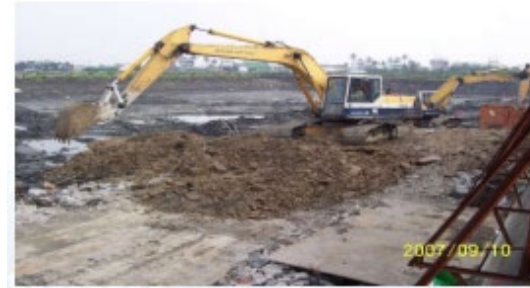
基地整地施工
