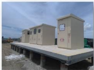
單元升壓站設備安裝
