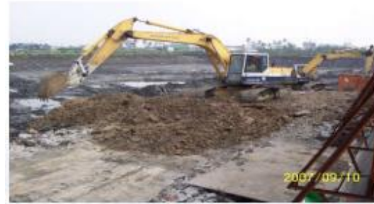
基地整地施工
