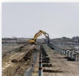
支架基樁工程
