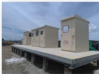
單元升壓站設備安裝
