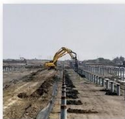
支架基樁工程
