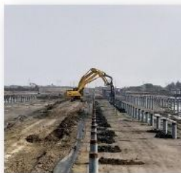
支架基樁工程
