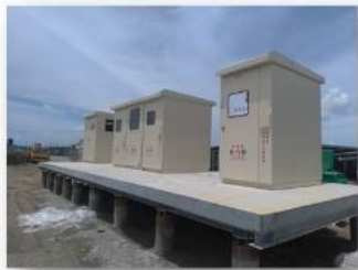
單元升壓站設備安裝
