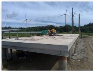
單元升壓站建置
