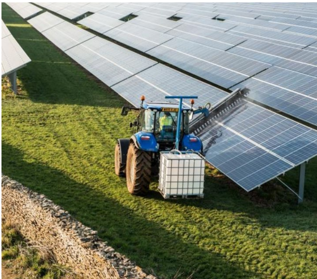
Figura 20 Limpeza de painéis com água osmótica num parque solar da Lightsource bp.
